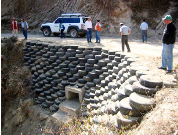
Foto 5, Muro de llantas para protección de camino rural en San Marcos. Guatemala
