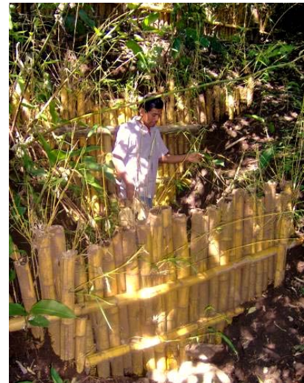
Foto 6, Barreras naturales para estabilizar terrenos en El Salvador
