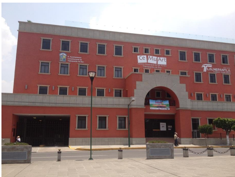
Imagen 11. Edificio del Centro Municipal de Mediación y Conciliación Tlalnepantla de Baz (CEMUART)
