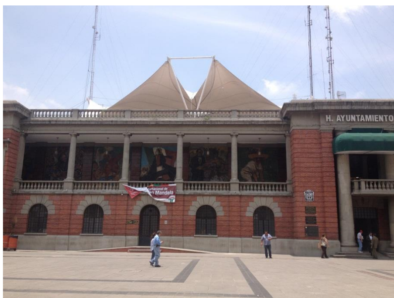
Imagen 7. Explanada del Municipio de Tlalnepantla de Baz, vista fachada. Con nueva estructura metálica y techumbre blanca que cubre el Claustro “Jorge Fons”
