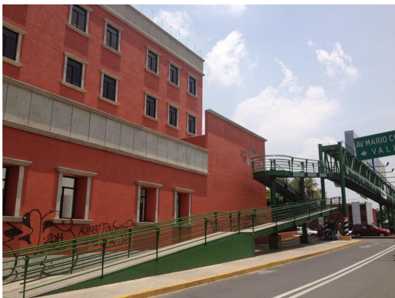
Imagen 12. Puente metálico con rampas para acceso flexible.
