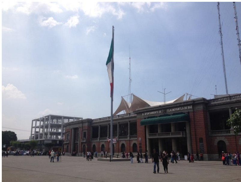
Imagen 6. Explanada del Municipio de Tlalnepantla de Baz, fechada. Con nueva infraestructura. Estructura metálica del nuevo edificio de la Comisaría General de Seguridad Ciudadana
