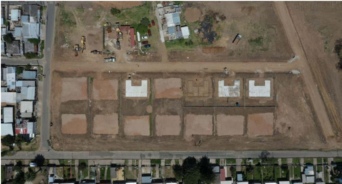
Imagen 17. Inicio del proceso de construcción de viviendas CONVIVE, Piedras Blancas (Fotografía propia, Intendencia de Montevideo, 2024).
