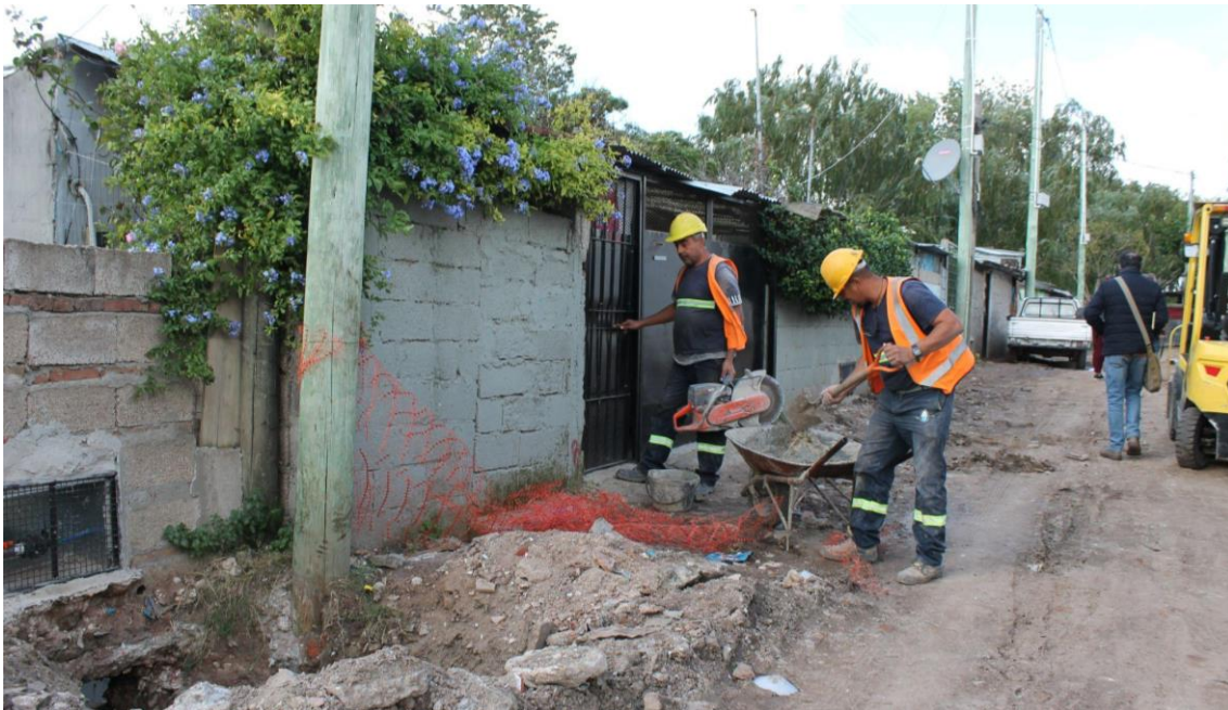
Imagen 12. Conexiones a Saneamiento en barrio Aquiles Lanza - Malvín Norte (Fotografía propia, Intendencia de Montevideo, 2025).
